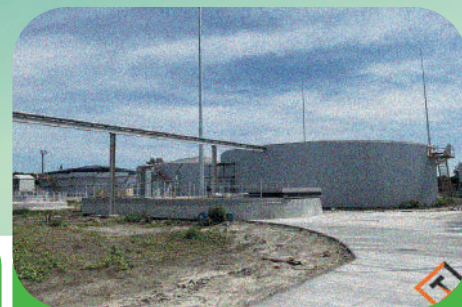
Курская область. Биогазовая станция «Ворошнево» Мощность 2,1 МВт. Количество поступающих отходов около 90 тыс. тонн в год.
