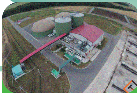
Белгородская область. Биогазовая станция «Лучки» Мощность 3,6 МВт. Количество поступающих отходов около 90 тыс. тонн в год.
