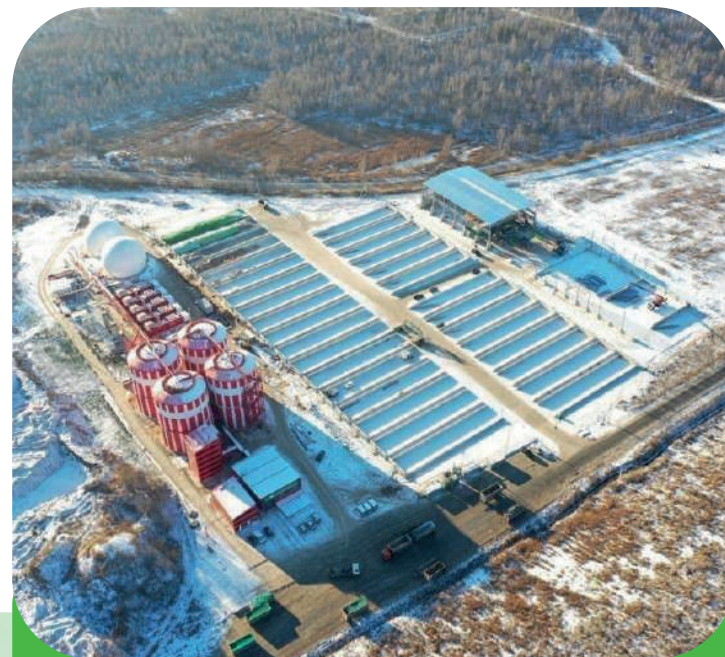
Московская область. Биогазовая станция «Тимохово» Мощность 10 МВт. Количество поступающих отходов около 200 тыс. тонн в год
